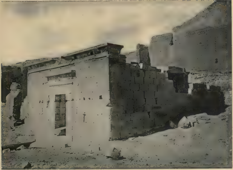
Avant la restauration.
